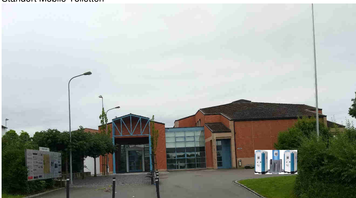
Standort Mobile Toiletten
